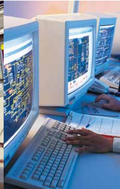
Die klassische Leitwarte (l.) hat nahezu ausgedient. Heute lässt sich die gesamte Prozesssteuerung am Computerbildschirm regeln (r.)
